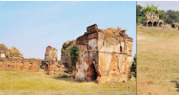
बेहद जीर्ण-क्षीर्ण अवस्था में है झारखंड के गुमला जिले में स्थित 900 साल पुराना नवरतनगढ़ किला
