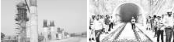
सोहना में वेस्टर्न डेडिकेटेड फ्रेट कॉरिडोर रेल के लिए बनाए जा रहे 20 से 60 फुट ऊंचाई वाले पिल्लर। रेल के लिए तैयार की गई 'डबल कंटेनर' रेल लाइन की फाइल फोटो।
