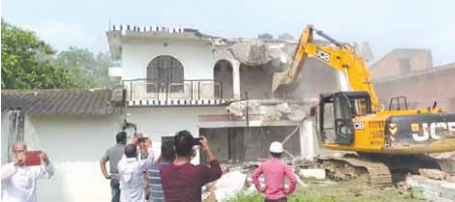
खान मुबारक के मकान को गिराता बुल्डोजर
