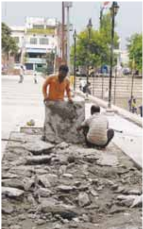
सीतापुर-हरगांव कुंड में हो रहा निर्माण कार्य
