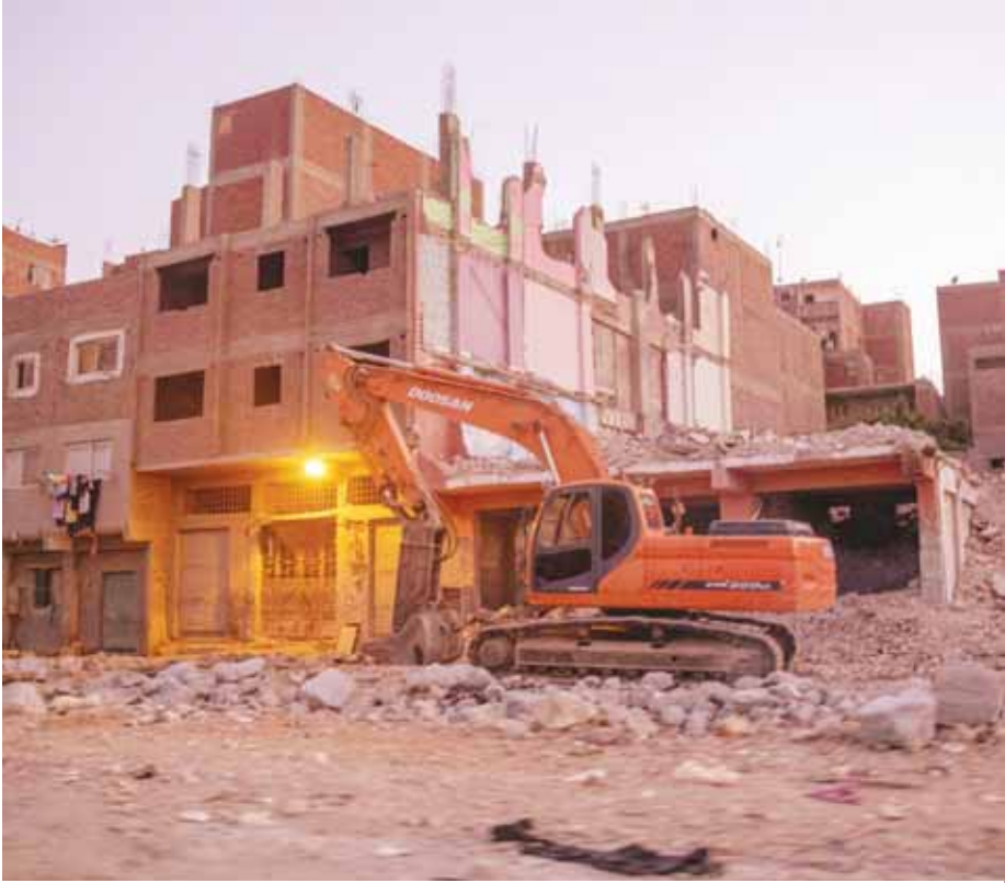
काहिरा में एक मेगा प्रोजेक्ट अमियान के तहत लोगों को मीडाइस से राहत देने के लिए नए शहर, सड़कें, पुल और सुरंग बनाने के लिए धरों को ध्वस्त करता बुलडोजर
