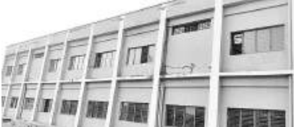
सीएचसी पिनगवां भवन उद्घाटन से पहले ही रिपेयरिंग के हालात।
