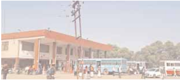
सामान्य बस स्टैंड परिसर के बीचों-बीच जा रही बिजली की हाई टेंशन लाइन।
