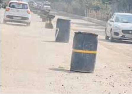
गुरुग्राम में एनएच-48 से पटौदी रोड तक सड़क निर्माण के लिए की गई तैयारी।
