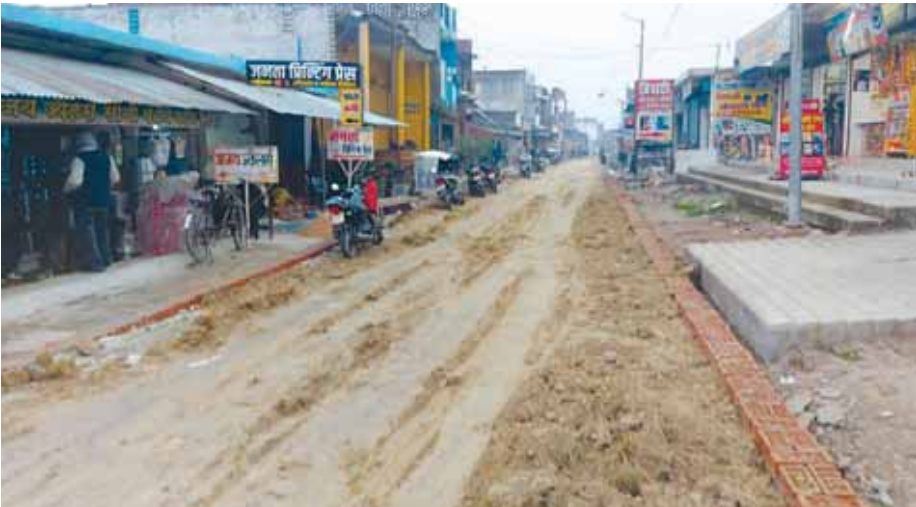
रुधौली में मानक विहीन हो रहा सड़क का निर्माण
