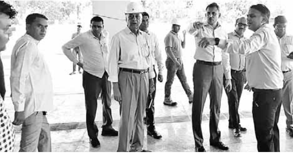
एनआईटी में निर्माणाधीन बस स्टैंड के कार्य का निरीक्षण करते परिवहन विभाग के प्रधान सचिव आईपीएस नवदीप विर्क।
