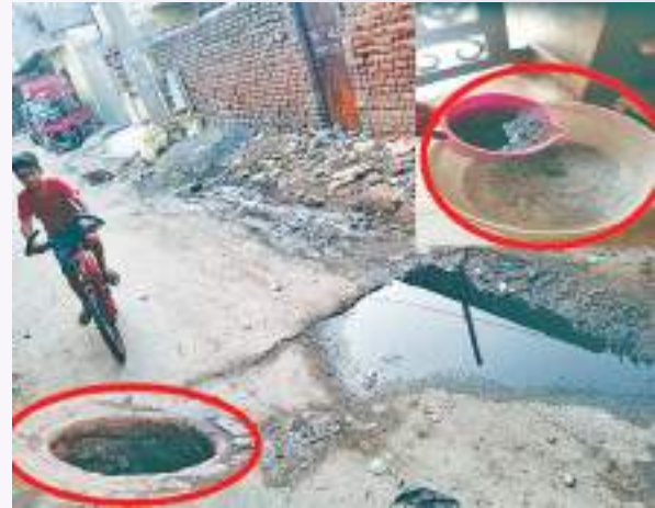
फ्रेंड्स कालोनी में सीवरेंज ओवरफ्लो, खुले मैनहॉल के ढक्कन और सप्लाई का गंदा पानी।
