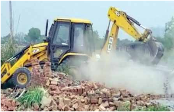
एक्सप्रेसवे किनारे बसाई जा रही अवैध कॉलोनी में हुए निर्माण को ध्वस्त करता प्राधिकरण का बुलडोजर।
