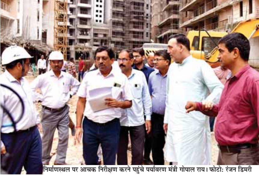
निर्माणस्थल पर आचक निरीक्षण करने पहुंचे पर्यावरण मंत्री गोपाल राय। फोटो: रंजन डिमरी
