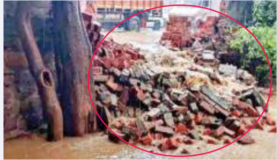
टूटी दीवार से झरने या नदी की तरह बहकर सड़क से आता बरसाती पानी।
