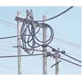
सोहना में बिजली की लाइनों से नंगी तारों को बदल लगाई जा रही केवल।
