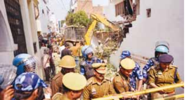
प्रयागराज में माफिया अतीक अहमद के करीबी जफर अहमद के अवैध मकान को तोड़ता बुलडोजर
