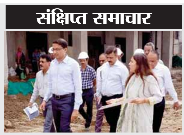
सीओ लोकेश एम ने निर्माणधीन अंतरराष्ट्रीय गोल्फ कोर्स का निरीक्षण किया।
