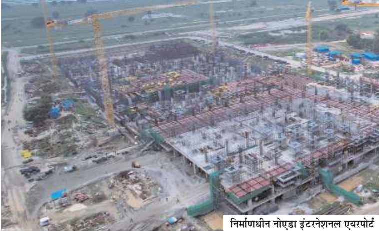
निर्माणधीन नोएडा इंटरनेशनल एयरपोर्ट
