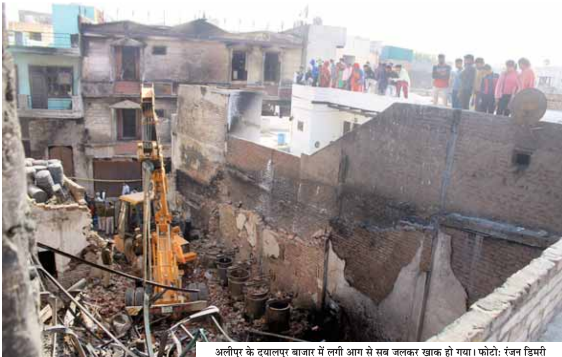
अलीपुर के दयालपुर बाजार में लगी आग से सब जलकर खाक हो गया। फोटो: रंजन डिमरी
