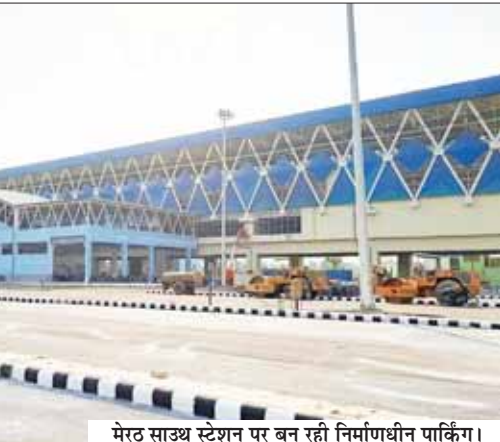
मेरठ साउथ स्टेशन पर बन रही निर्माणधीन पार्किंग।
